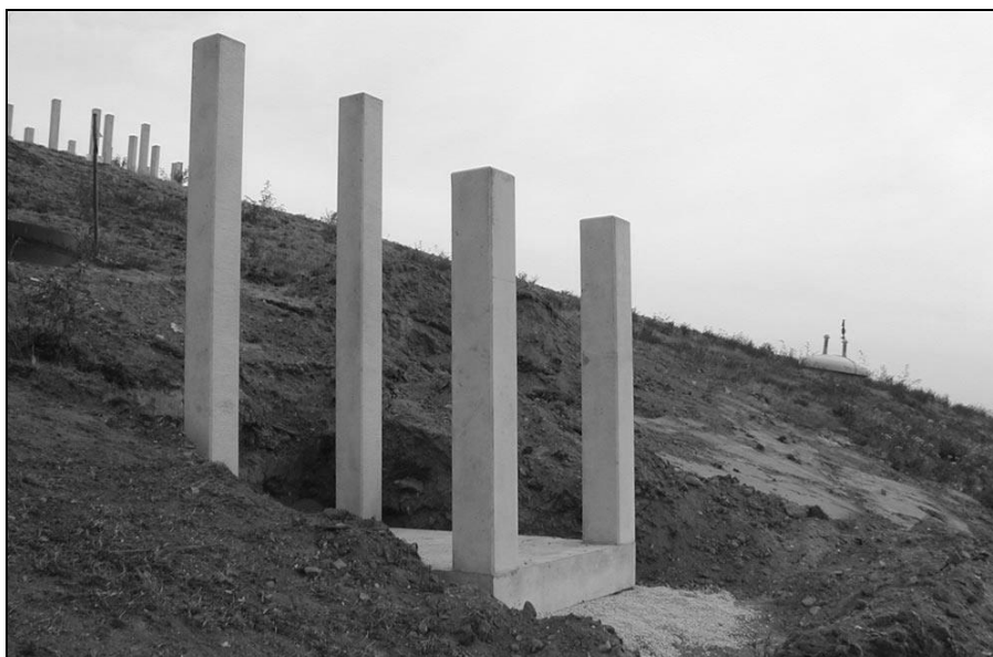
Abbildung 4 Deponie Atzenhof, Einbau der Modultische in die Endabdeckung der Deponie (Gerdenitsch, 2004)
