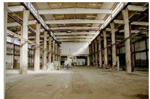
Innenansicht einer Produktionshalle
