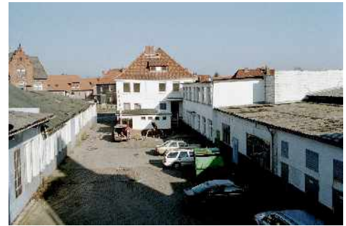
Ansicht des Zufahrtbereiches
