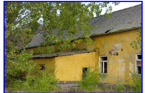
Dachdeckungen mit Asbestzement
