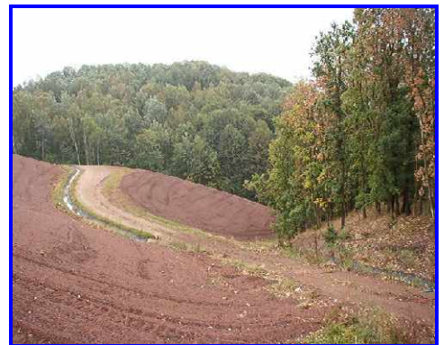
Temporäre Abdeckung mit Berme
